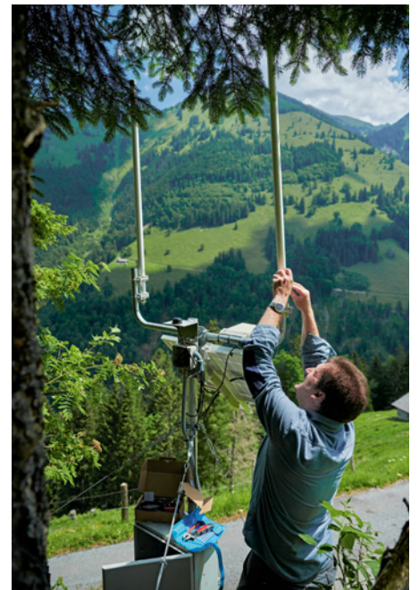
Ein Update der Antenne ermöglicht neu eine Datenübermittlung in beide Richtungen.
