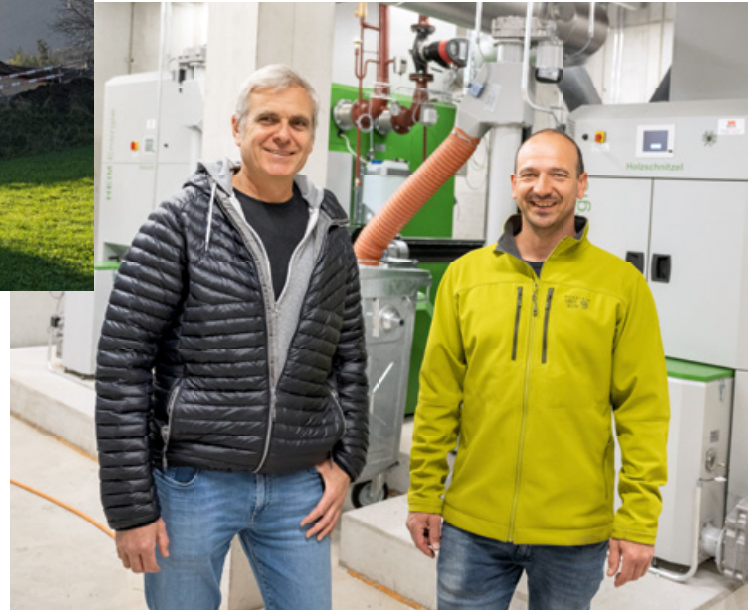
Reto Cossalter (links) und Christoph Zwicky vor den beiden grossen Holzschnitzel-Öfen der neuen Heizzentrale.
